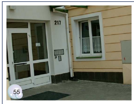
Vchod do DPS Hrotovice. První chybou je velká vzdálenost mezi zvonky s domovním telefonem a dveřmi, další je pak sklon chodníku hned za dveřmi, který je cca 1:15.
